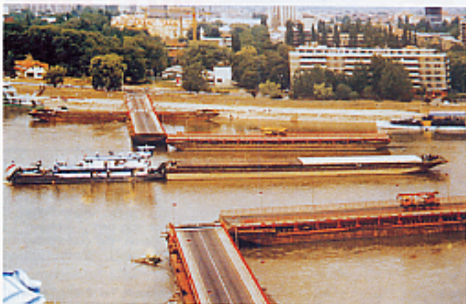
Geöffnete mautpflichtige Ersatzpontonbrücke
